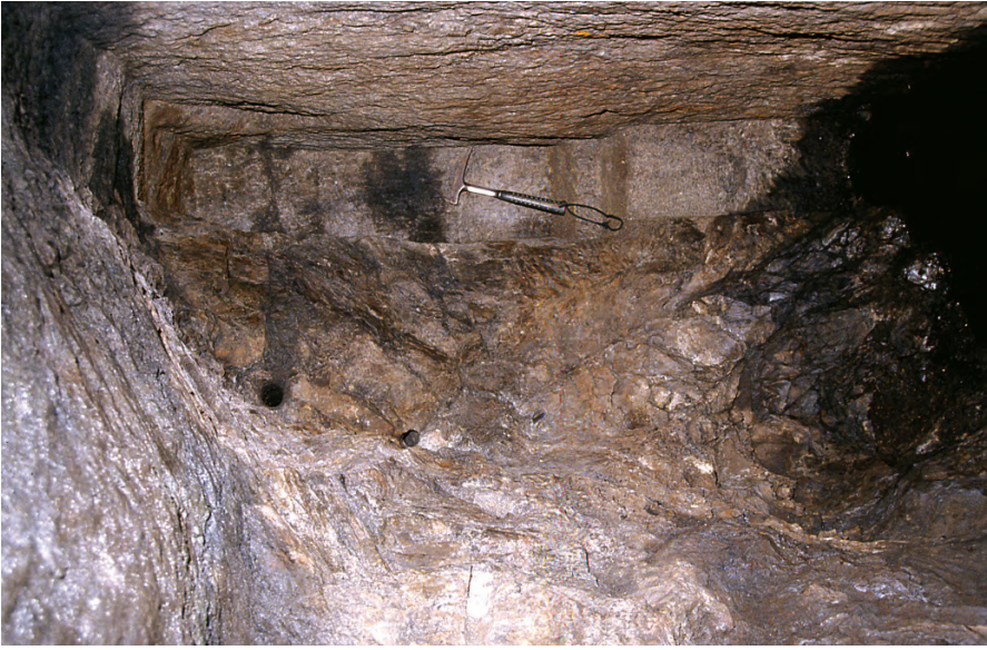
▼ Fig. 32. Sieberstollen im Bereich der Grube Felicitas, Mitte der 1730er Jahre aufgeföhren. Der rechte Stoß ist von Hand „vorgeschrämt“ und der linke Stoß „nachgeschossen“. Ein in den 1930er Jahren aus Beton gegossener Steg ersetzt heutige das frühere hölzerne Tretwerk
