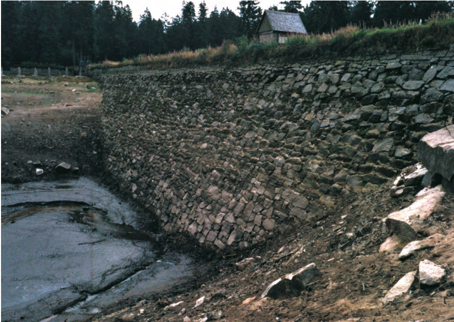
Fig. 28. Blick auf den Damm des vollkommen entleerten Oderteiches im August 2003. Gut zu erkennen ist das aus Granitquadern zusammengefügte „Zyklopmauerwerk“
