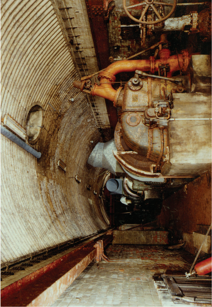
Fig. 25. Turbinenhalle im Schacht Kaiser Wilhelm II auf der Ernst-August-Stollensohle, 368 m unter Tage. Das 1895 eingerichtete, bis zum 31. März 1980 betriebene Kraftwerk hatte eine Leistung von 4,5 MW (Foto: 1982)
