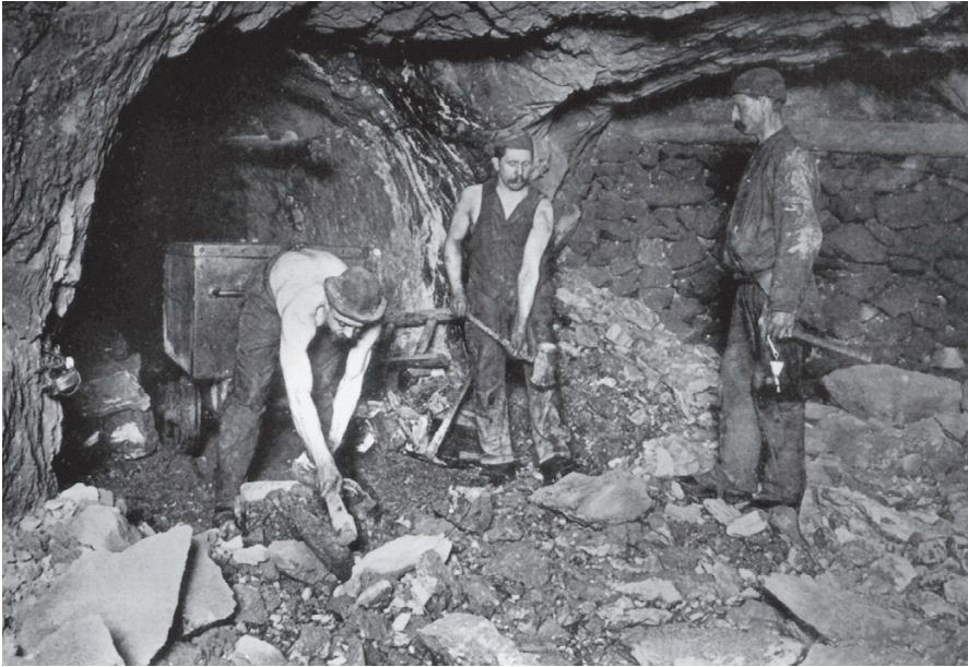
Abb. 5.13. Erzscheidung im Abbau, auf der 19. Strecke, 640 m westlich vom Schacht Kaiser Wilhelm II, 769 m unter Tage. Mit einem schweren Vorschlaghammer werden die großen Erzstücke zerkleinert, anschließend wird das erzhaltige Haufwerk mit „Kratze und Trog“ in den Förderwagen geladen (linke Bildhälfte). Rechts steht ein Steiger mit „Frosch“ und Fahrstock in der Hand
