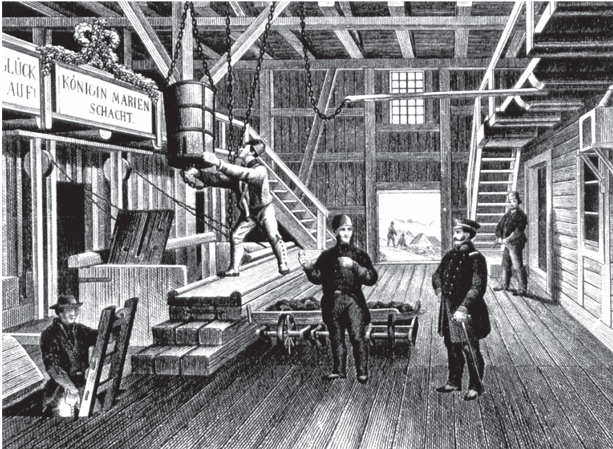
Abb. 8.9. Blick in den Gaipel des Königin-Marien-Schachtes östlich von Clausthal. Links der Fahrschacht, rechts daneben der Treibschacht mit einer darüber hängenden Tonne. In der Bildmitte stehen ein Grubensteiger und ein Einfahrer. Am 28. März 1878 ereignete sich ein schweres Unglück, als beim Einsturz der untertägigen Kehrradstube acht Bergleute begraben wurden, von denen drei ums Leben kamen. Im Jahre 1906 verunglückten hier vier Bergleute bei Schachtarbeiten tödlich (Stahlstich nach einer Zeichnung von W. Ripe um 1860)
