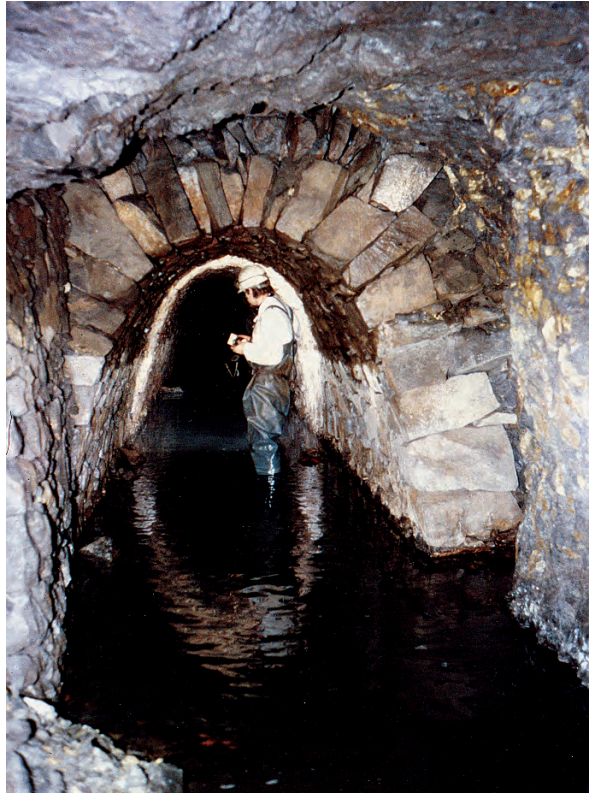
Fig. 20. ▼ Schachthanlage Kaiser Wil- helm II, obere 4. Strecke; Rund- bogenausbau mit Steinverzug
