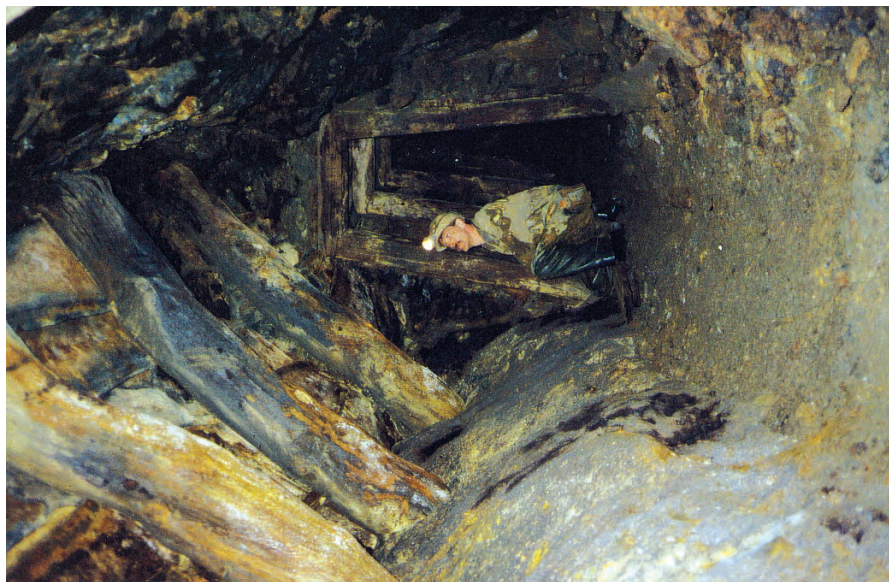
▼ Fig. 49. Grube Glasebach bei Straßberg, alter Firstenverzug auf der 5. Sohle-West (Foto: G. Hintze 1991)
