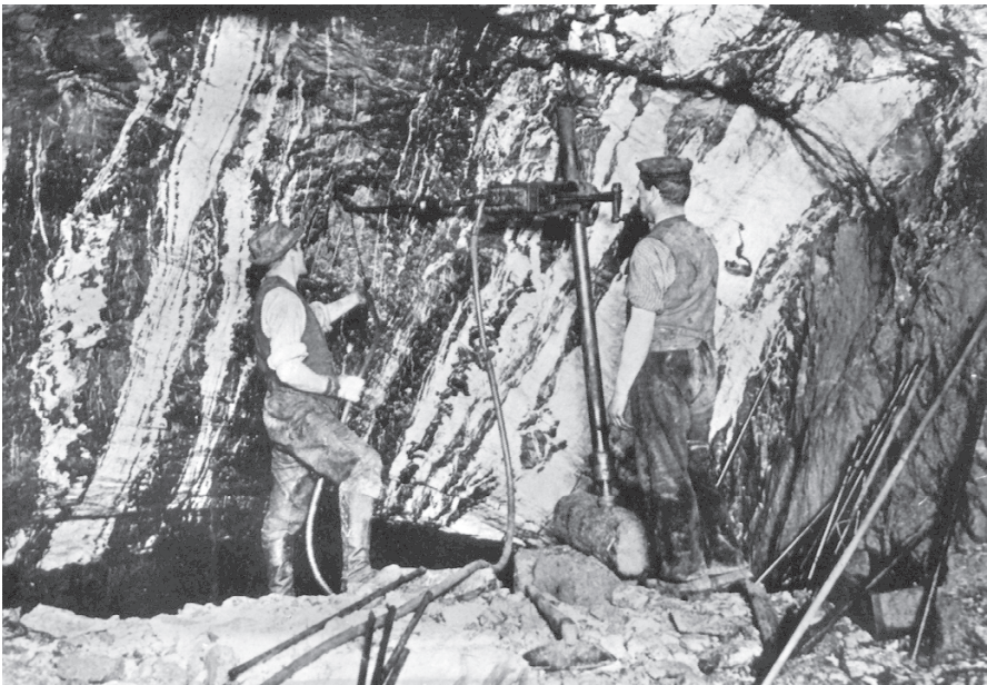
Abb. 5.12. Bohrmaschinenbetrieb im Firstenstoßbau auf der 20. östl. Strecke des Schachtes Kaiser Wilhelm II in Clausthal, 811 m unter Tage. Die damals verwendeten Bohrhämmer hatten noch keine integrierte Wasserspülung, so dass hier ein zweiter Bergmann mit einem Wasserschlauch den Bohrer kühlt und gleichzeitig den gesundheitsschädlichen Quarzstaub (Silikosegefahr!) bindet. Sehr gut ist auf dieser Aufnahme die Bänderung des Erzganges (hell Kalkspat und Quarz, dunkel Zinkblende und Bleiglanz) zu erkennen
