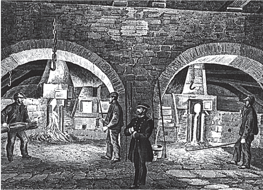
Abb. 6.13. Das Innere der Treibhütte (Clausthaler Hütte). Dargestellt sind zwei Treiböfen, an denen Silberabtreiber mit Glätthaken die Bleiglätte abziehen. Links im Bild bringt ein Schürknecht ein Bündel Fichtenäste (sog. Waasen), die bei der Verbrennung eine sehr starke Hitze erzeugen (Stahlstich nach einer Zeichnung von W. Ripe um 1850)
