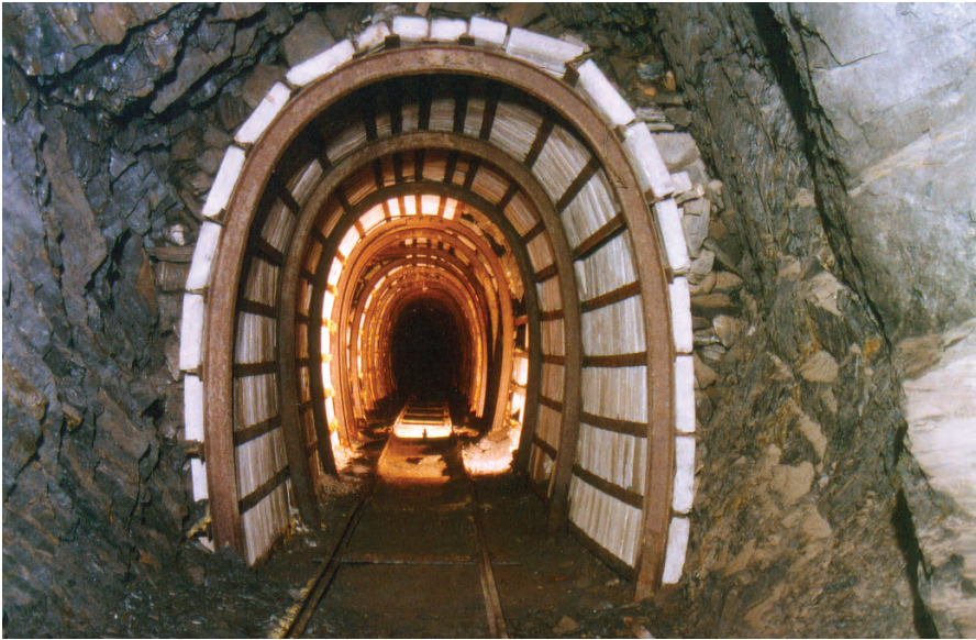
Fig. 20. ▼ Schachthanlage Kaiser Wil- helm II, obere 4. Strecke; Rund- bogenausbau mit Steinverzug
