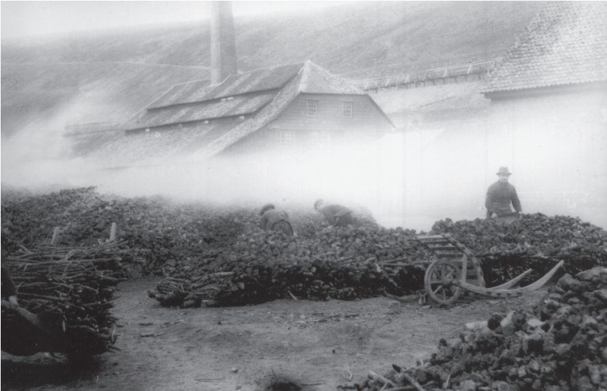
Abb. 6.16. Haufenröstung von Bleistein auf der Clausthaler Hütte. Die Leute arbeiten vollkommen ungeschützt in den dichten Rauchgasschwaden (Foto: Zirkler um 1900, Harzbibliothek Clausthal)
