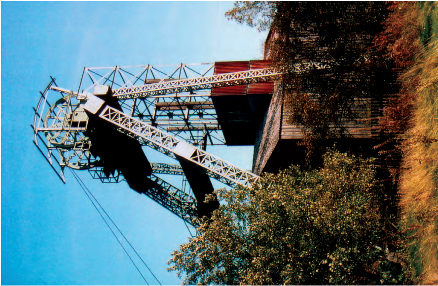
▼ Fig. 13. Fördergerüst des Ottiliae-Schachtes westlich von Clausenthal, von 1870–1930 Hauptförderschacht; ältestes stählernes Fördergerüst Deutschlands!
