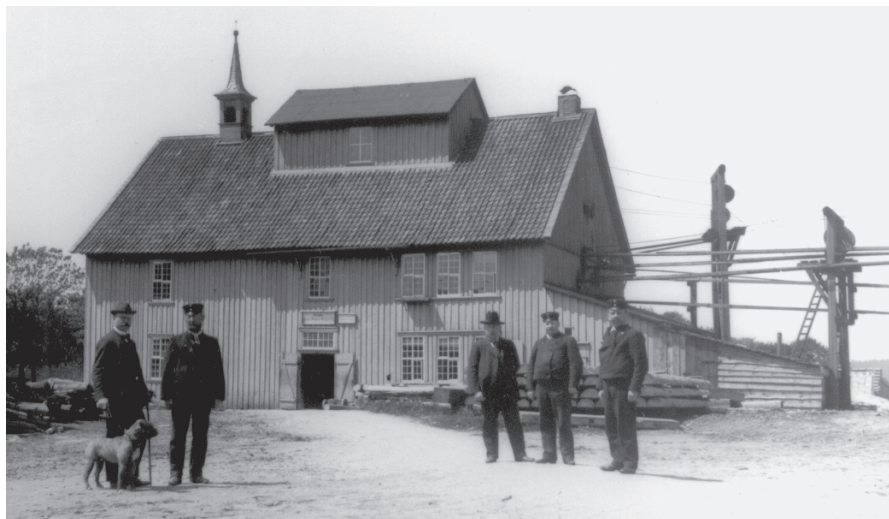
Abb. 4.11. Gaipel der Grube „Neuer Thurm-Rosenhof“ über dem 720 m tiefen Schacht. Bis 1928 zeigte das Glöckchen im Dachreiter, ob die Pumpenkunst und damit auch Fahrkunst im Gange war. Rechts im Bild erkennt man die Böcke über die die Förderseile vom Kehrrad zum Schacht geführt werden (Foto: von Zirkler um 1905)
