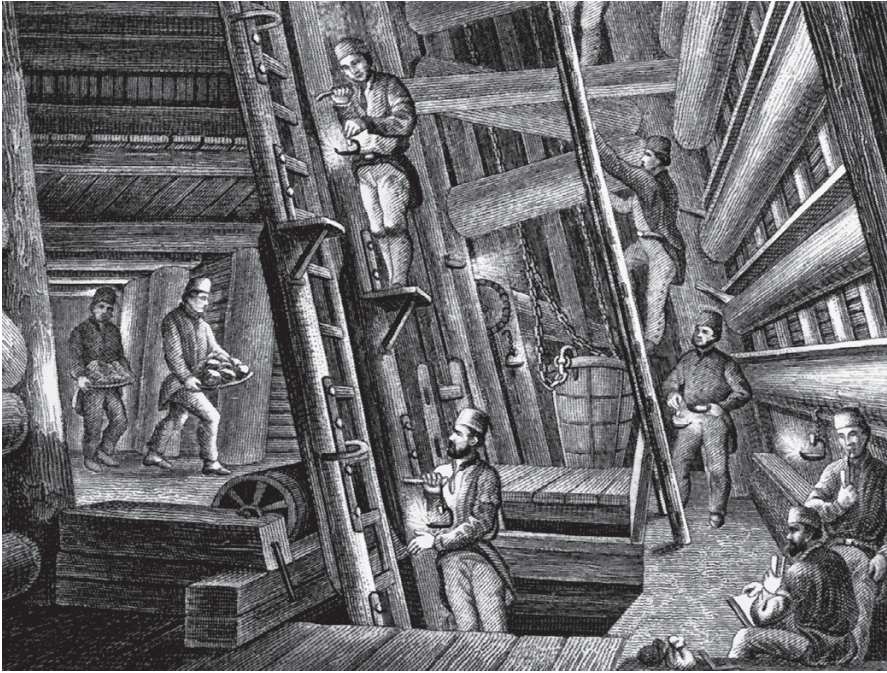
Abb. 5.26. Die Fahrkunst im Dorotheer Schacht auf dem 19-Lachter-Stollen. Rechts daneben das Fahrtenrum und im Hintergrund der Treibschacht mit einer hölzernen Fördertonne. Diese 65 Lachter (etwa 130 m) unter Tage befindliche Sohle war die sogenannte Fremdenstrecke, auf ihr wurden die zahlreichen Besucher hinüber zur Nachbargrube Caroline geführt (Stahlstich nach Zeichnung von W. Ripe um 1850)
