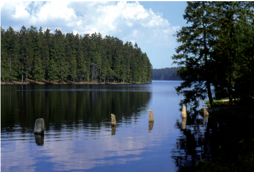
Fig. 29. Blick auf den gefüllten Oderteich, im Vordergrund die aus Granit gefertigten Eisabweiser vor der Ausflut
