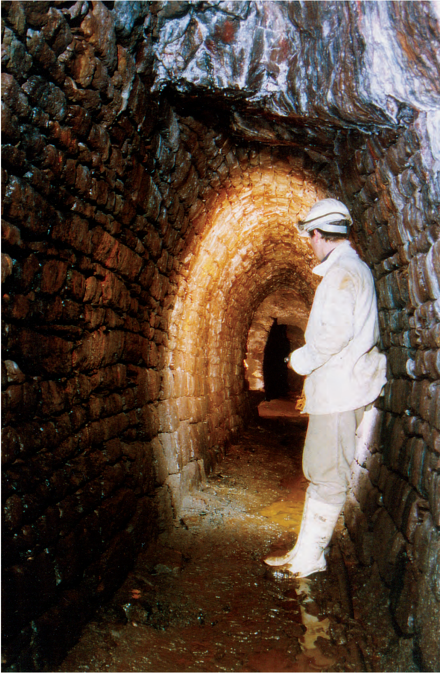
Fig. 46. Formvollendetes Trockenmauerwerk im Charlottenstollen am Büchenberg b. Elbingerode (Foto: 1992)
